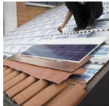
Posa del primo modulo
