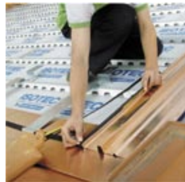
Posa delle guarnizioni
